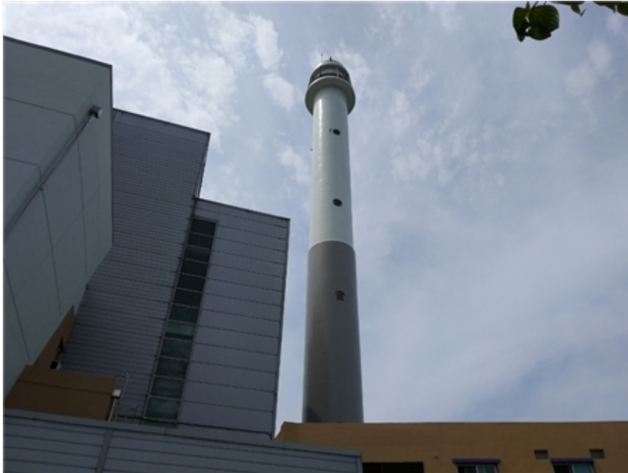
소각시설 굴뚝 (항공장애표시등)
